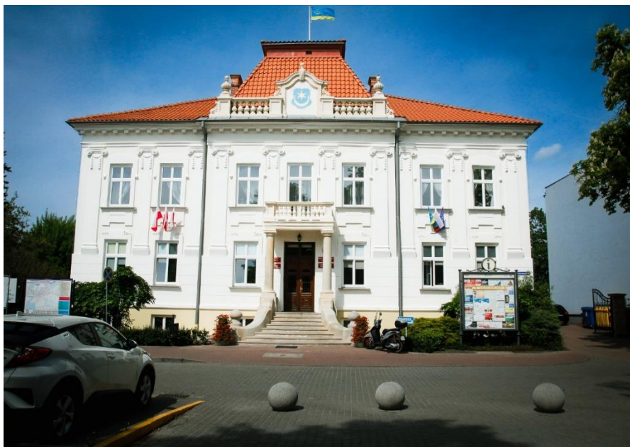
Galeria zdjęć 7. Remont zabytkowego budynku dawnej Cesarsko-Królewskiej Wyższej Szkoły Realnej.
