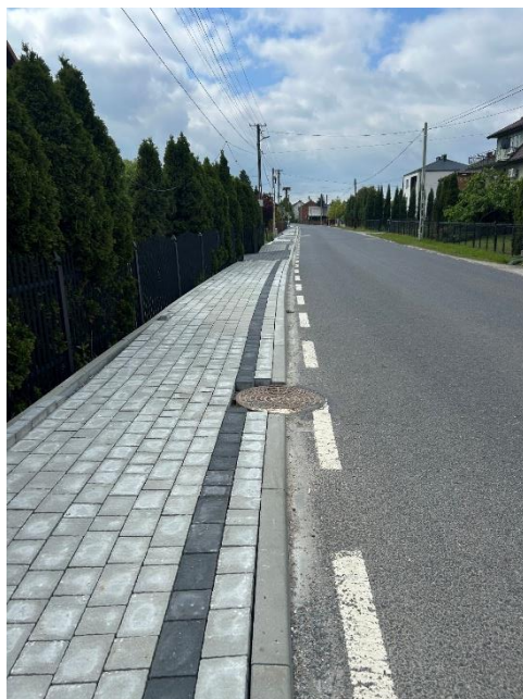
Galeria zdjęć 6. Wykonanie chodnika przy ul. Szlacheckiej.
