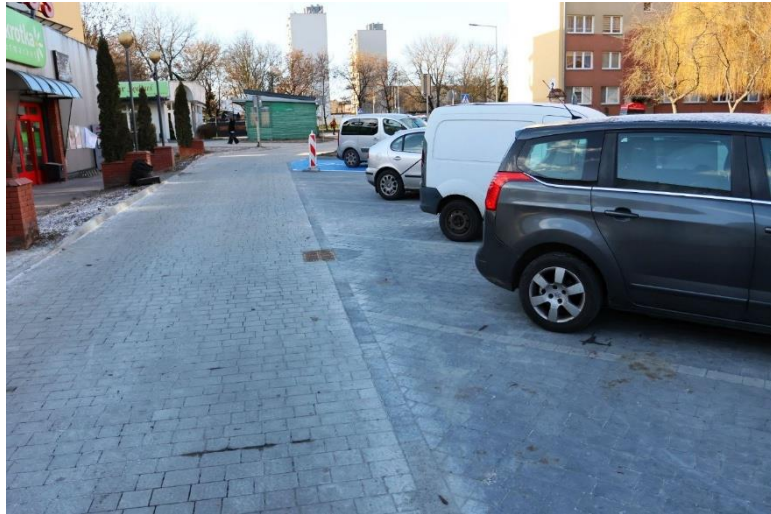
Galeria zdjęć 5. Odbudujmy Serbinów - Remont i przebudowa parkingu i drogi dojazdowej.
