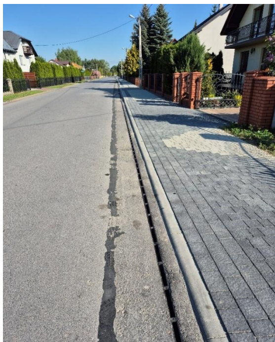
Galeria zdjęć 2. Budowa chodnika na ul. Sieleckiej w Tarnobrzegu.
