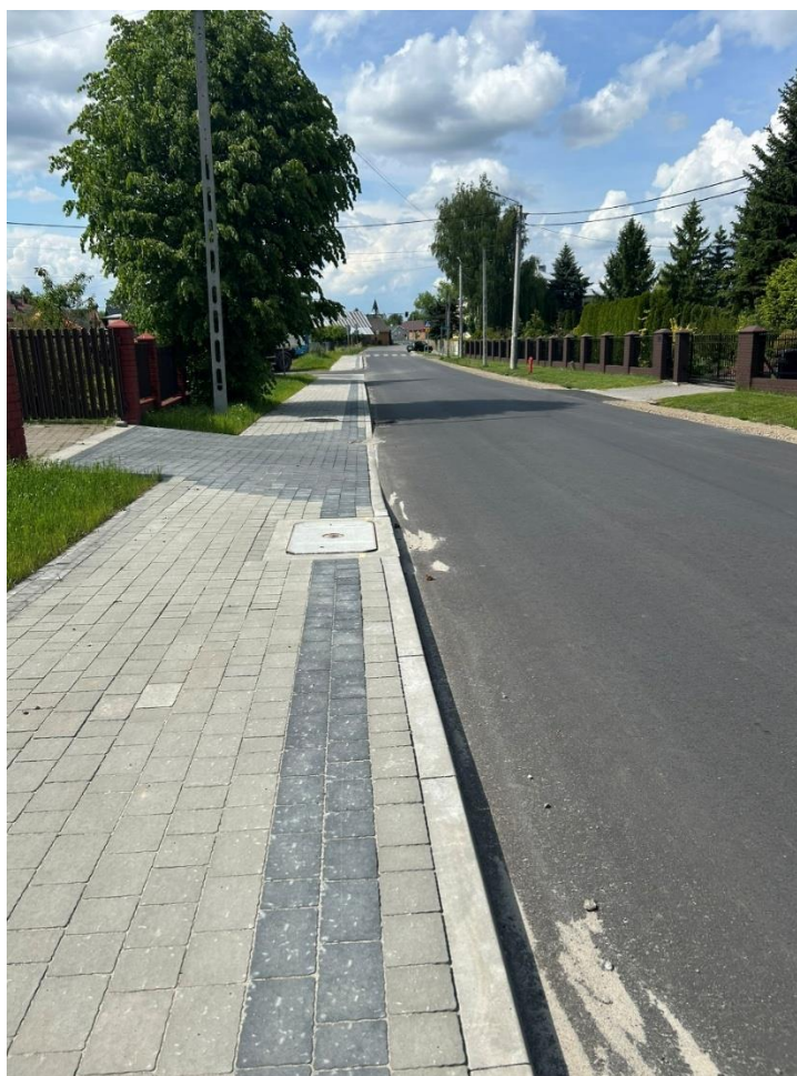
Zdjęcie 9. Przebudowa ul. Sobowskiej.
